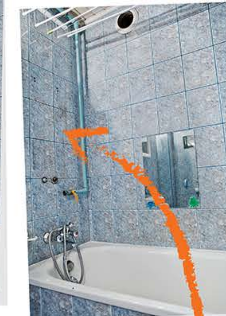
Demontaż starego piecyka gazowego, likwidacja instalacji gazowej i wykonanie otworu do komina spalinowego
