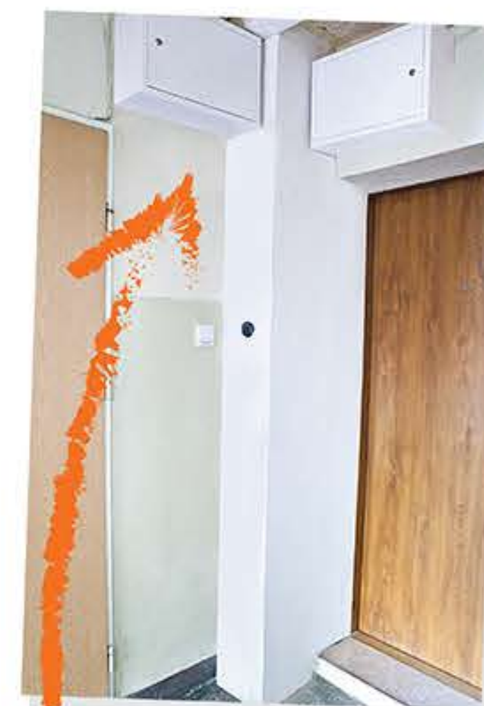
Montaż skrzynki pomiarowej na korytarzu, prace wykończeniowe i uruchomienie ciepłej wody użytkowej
