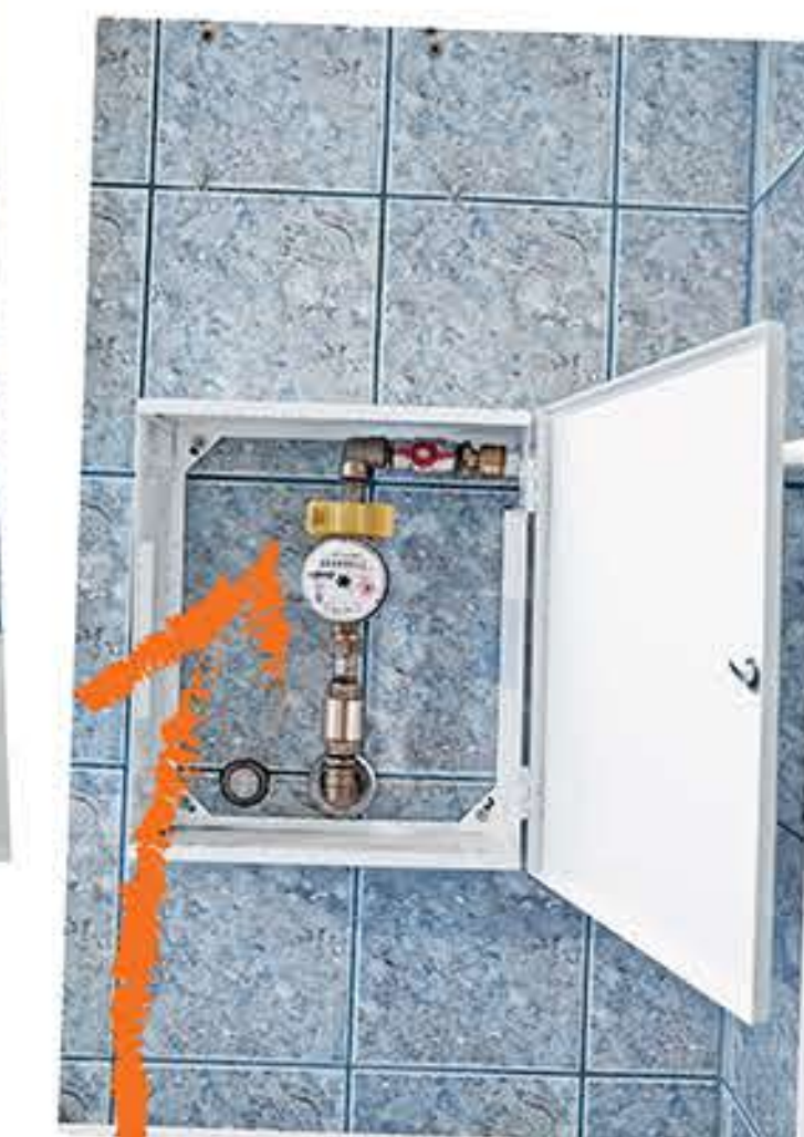
Montaż skrzynki pomiarowej, prace wykończeniowe i uruchomienie ciepłej wody użytkowej
